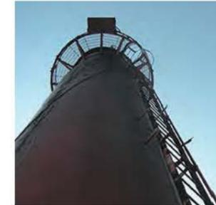
梯子や蹴場を利用し、目視または望遠カメラ等による点検や、板厚測定を行います。筒身の腐食、変形・穴あきや、塗膜の変色、剥離、発錆等について調査します。
