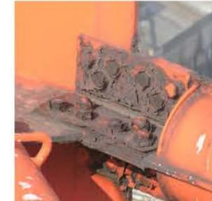
鉄塔部材や各部材交点の仕口、継手等を対象に目視点検を行います。部材の腐食、変形、破断や異常振動、接合部のボルトの緩み・抜け、発錆等について調査します。
