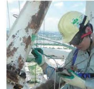
上記の一次点検で異常が認められた場合に詳細点検を行います。点検は煙突にゴンドラまたは吊り足場を設置する等の方法により、異常が発見されたエリアに近接して行います。目視、写真撮影の他、板厚測定やテストハンマーによる打診調査を行います。
