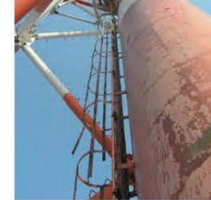
蹴場・小休憩所の床材や手摺、昇降設備、避雷設備、航空障害灯設備を対象に点検を行います。部材の腐食、変形・穴あき、破断やボルトの緩み・抜けがないか調査します。
